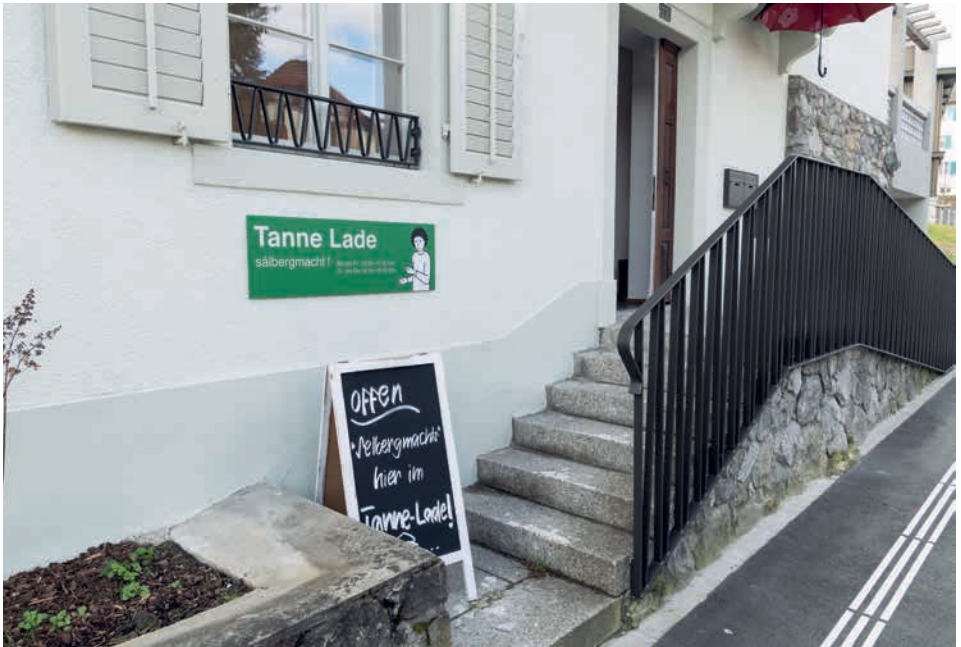
Zuvor war der Laden in Gattikon, neu ist er im Gebäude Alte Dorfstrasse 1.
